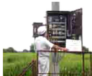
浸水した揚水機場の制御盤を交換することによりポンプ機能を回復
