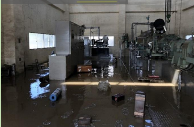
ポンプ設備の被害(倉敷市)
