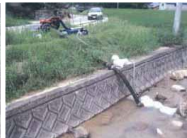
仮設ポンプを設置し、用水を確保
