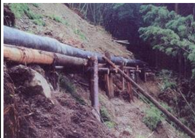
仮設水路を設置し、用水を確保
