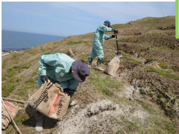
亀裂に土壌改良剤を挿入
