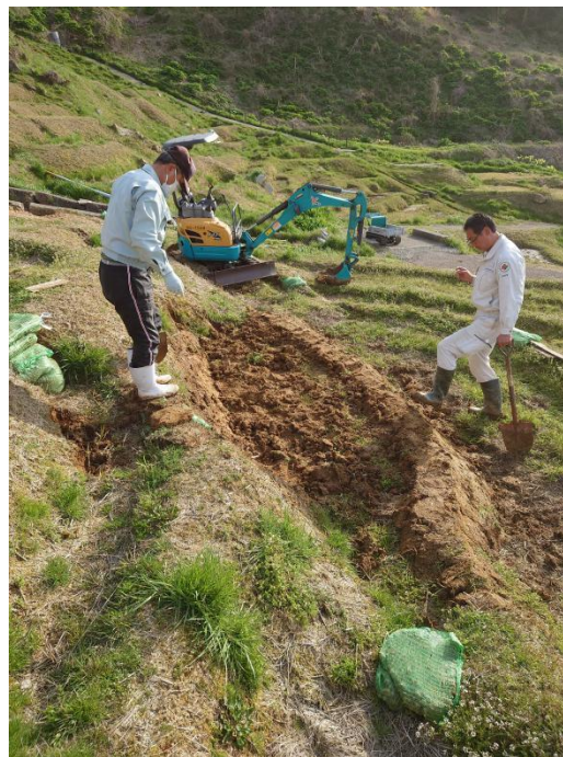
崩れた畔に土を盛り直す
