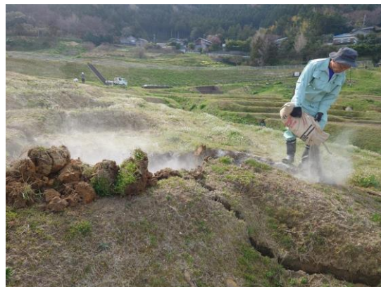
亀裂に土壌改良剤を挿入
