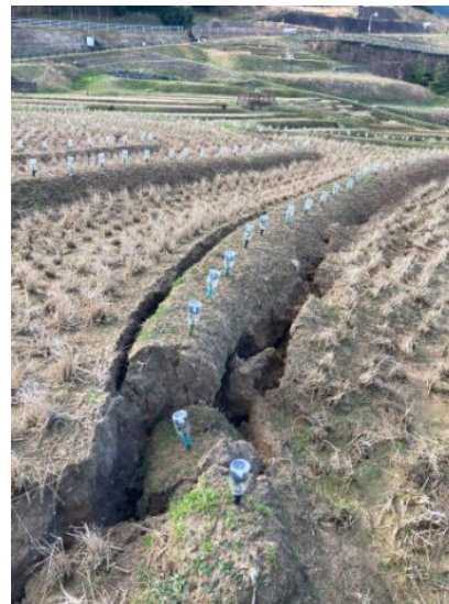
畦と土手に亀裂
