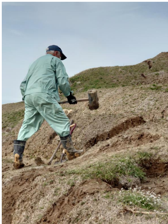
亀裂に入れた土を掛矢で叩く
