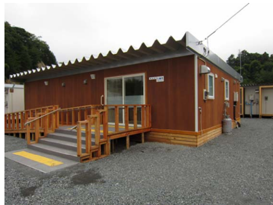
図9 瓦礫廃木材の再利用(チップ化(左)と復興ボード活用の集会所(右))
