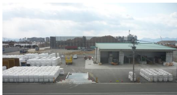
図 7 八代 TMR センター（混合飼料工場）
