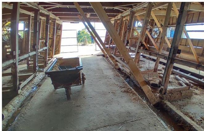
図 3 傾いた牛舎に補強の筋交い
